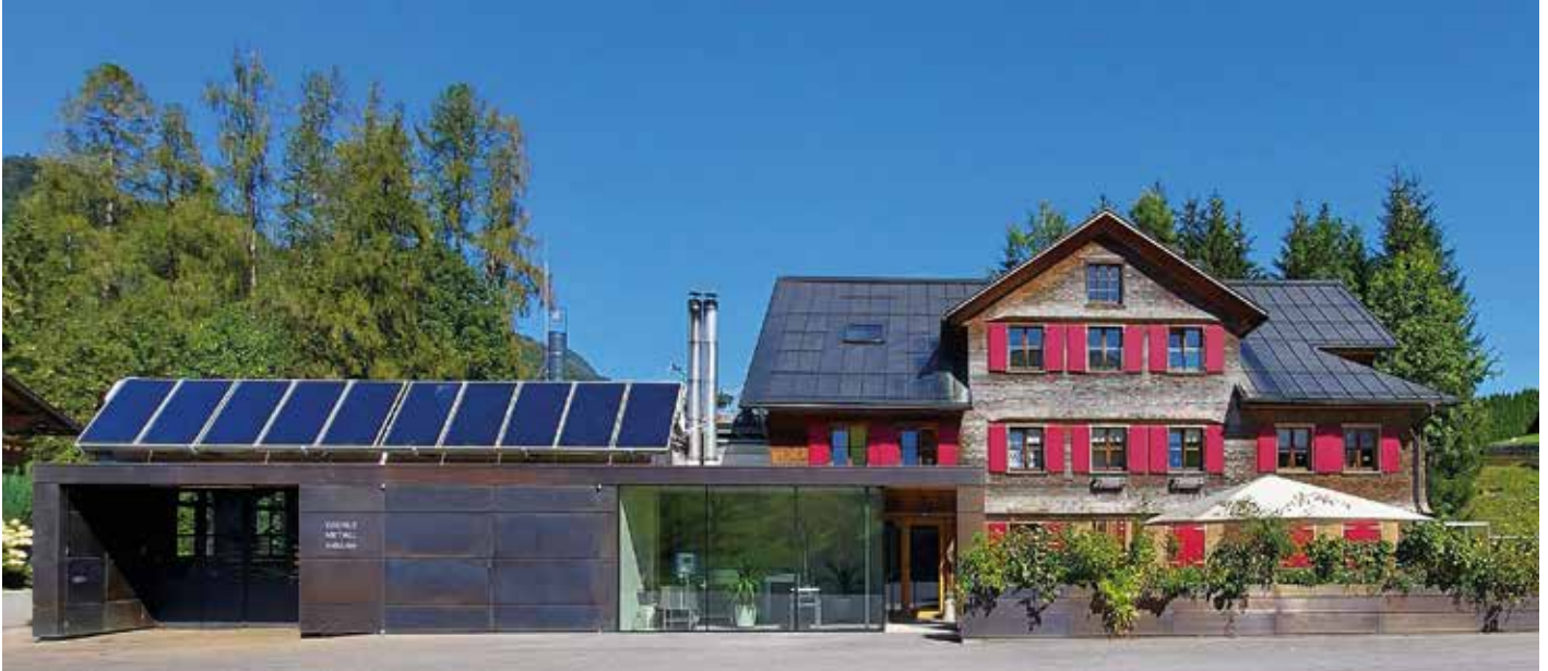
Erweiterung des Firmengebäudes: EBERLE Metall exklusiv
