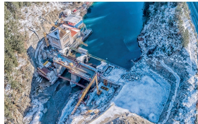
Perspektivenwechsel: Das Kraftwerk Kniepass wird derzeit umfassend modernisiert. Zur Erhöhung der Hochwassersicherheit wird ein drittes Wehrfeld gebaut. Die Kraft des Wassers bringt die Turbinenwelle (re.) in Rotation, die im Generator elektrischen Strom erzeugt.
