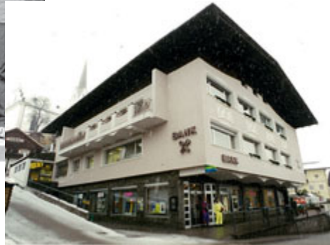
Das neue Gebäude lässt sich sehen – aus dem Jahr 1997.
