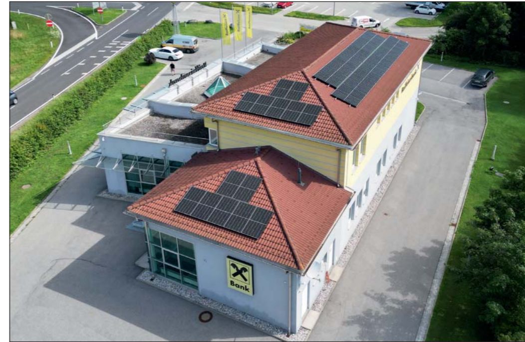
Auch das Gebäude des Drautalbank-Kundencenters Maria Saal erzeugt eigenen Strom mit Photovoltaikanlagen auf dem Dach.
